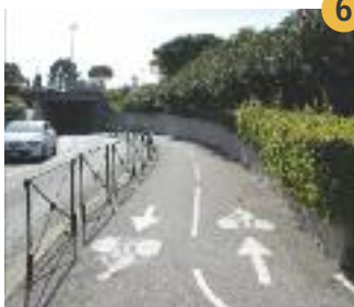
Liaison Port Ariane sécurisée sous le tunnel
