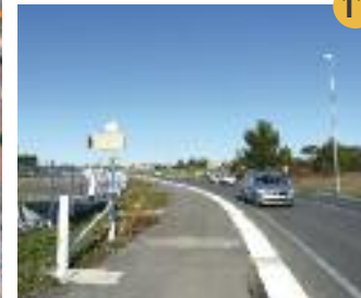
Au niveau du chemin de la Lironde, Lattes-Boirargues
